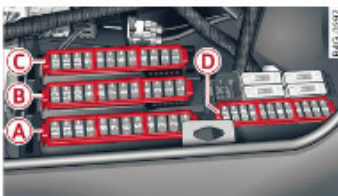
Obr. 263 Zavazadlový prostor: nosník pojistek s plastovým tmeňem
